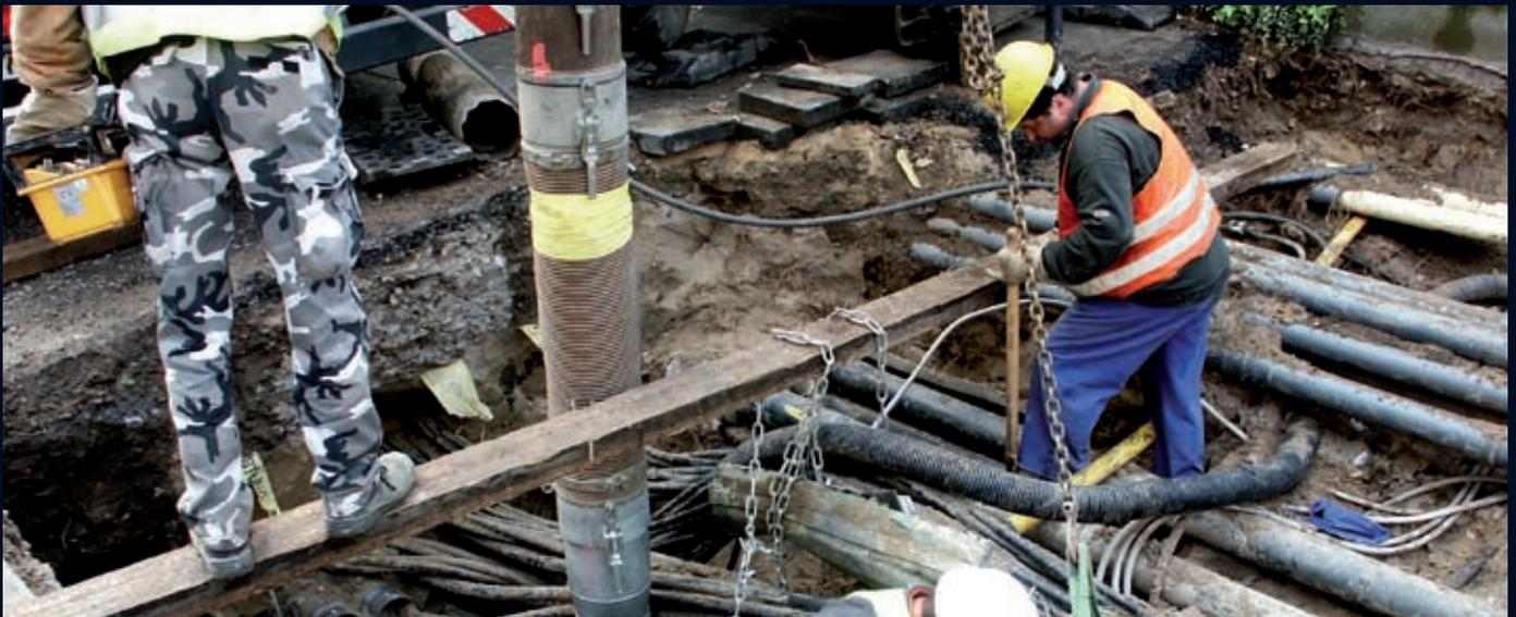
RSP - Saugbagger garantieren kürzeste Einsatzzeiten, schnellsten beschädigungsfreien Erdaushub, sowie geringe Verkehrs- und Umweltbelastungen.
